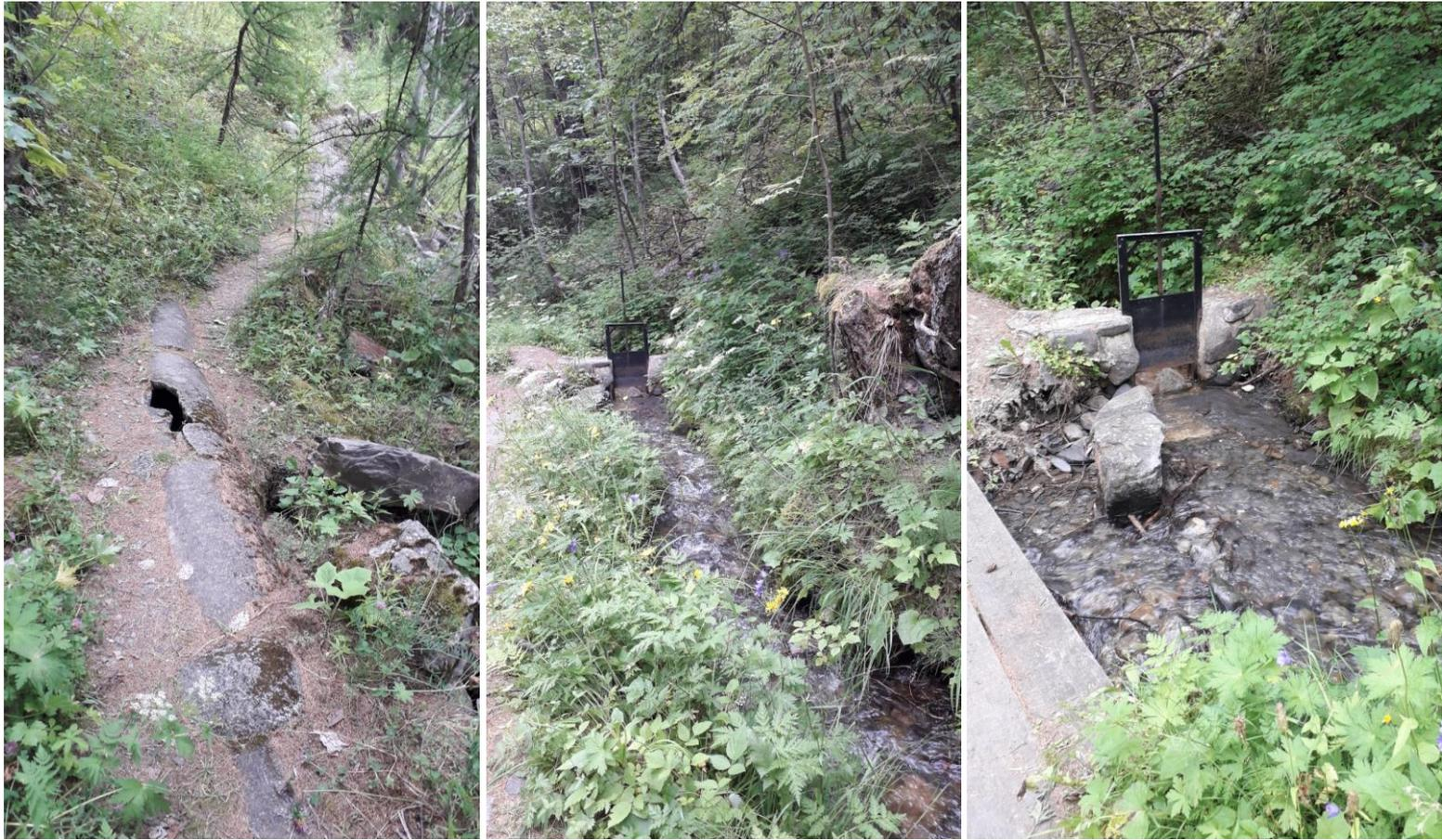
Figure 55 : Photographies d'un canal d'irrigation avec une partie souterraine, une partie aérienne et une vanne
